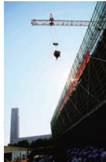
18/10月時点の工場建設状況
